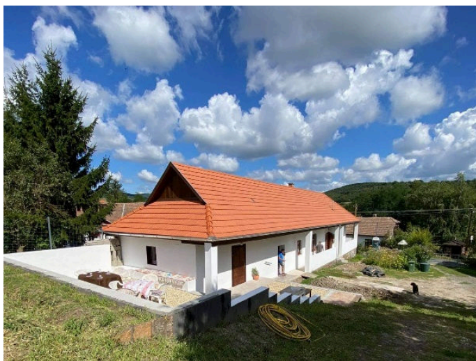
A Kossuth u. 7.sz. alatti ház. Ilyen volt, felújítás közben és ilyen lett
