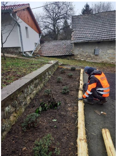
Készül a vízelvezetés és geoháló elhelyezése. A virágágyás előkészítése.
