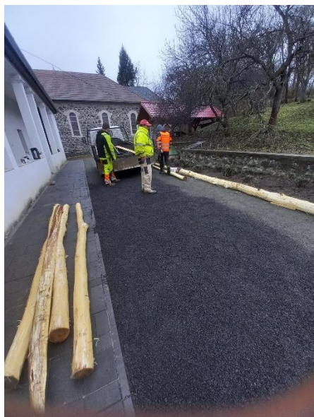
Készül a vízelvezetés és geoháló elhelyezése. A virágágyás előkészítése.
